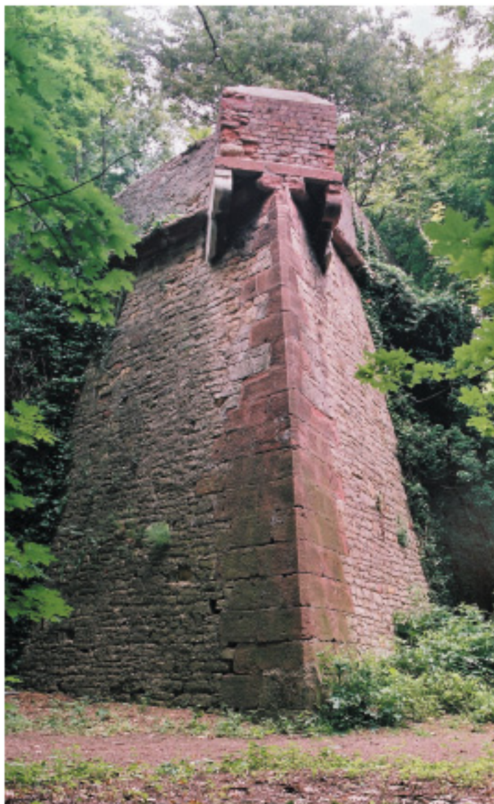
Bastion Druas - außen bereits fünf Meter freigelegt
